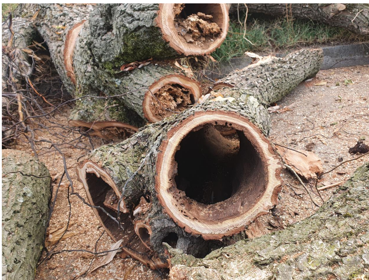
Esemplare di alberatura esteticamente bella ma pericolosa in quanto completamente cava.
